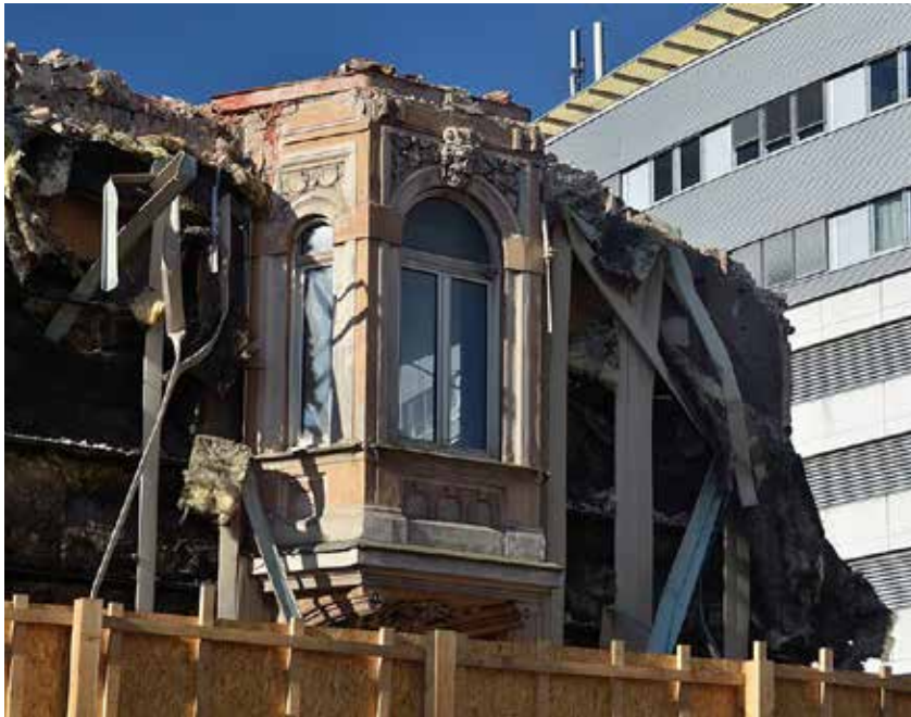
Altbau in Wien-Meidling: die Demolierung der historischen Bausubstanz kostet die Stadt nicht weniger als ihre Schönheit.
